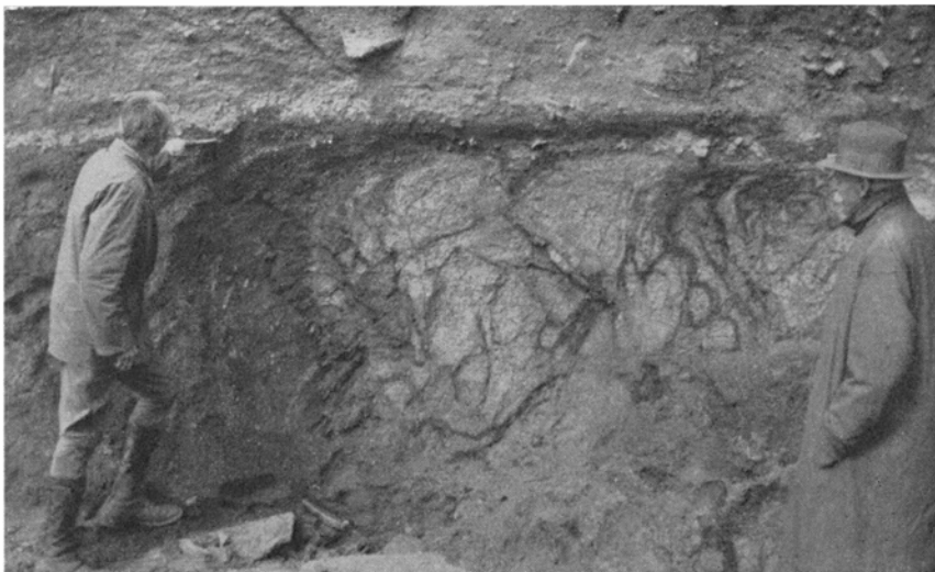
Fig. 2. Forvitret bergart ved Ullgjell. På dette sted har den vært tatt ut med hakke og spade og brukt som veigrus. På toppen ligger almindelig morene.
