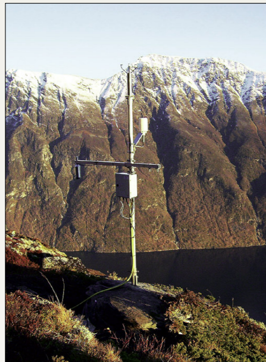
Klimastasjonen på Åknes registrerer vindretning og -hastighet, temperatur, nedbør, solinnstråling og snødybde. (Foto: L.H. Blikra)
